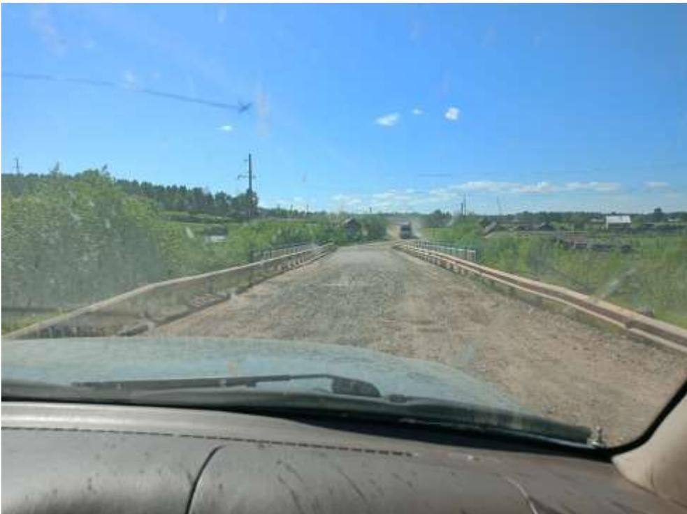
5. **ПП полевая дорога 23 км 2 к.с.** П. Никола-Петровка – г. Суханиха. Грунтовая дорога, резкие повороты, промоины, местами рыхлый песок, колея. Спуски и подъемы до 10 градусов. В жаркую погоду очень пыльная, местами видимость ограничена до 2 метров.
